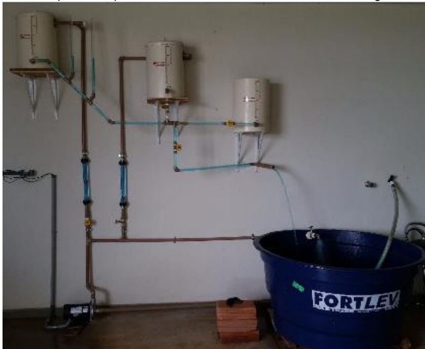
Figura 11 - Aparato experimental executado no Laboratório de Engenharia Civil
